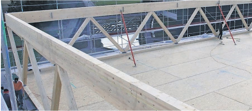
Ein aus Holz konstruiertes Dachgeschoss überspannt das ganze Gebäude.
